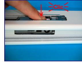
4. Colocar a fechadura na posição inferior (posição aberta). Colocar o sistema anti-falsa manobra (AFM) com a seta direccionada para a zona de saída da língua de fecho
